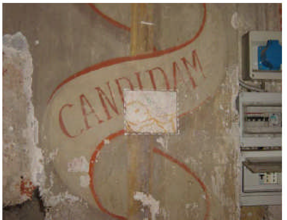
INDAGINI STRATIGRAFICHE SUGLI INTONACI INTERNI
