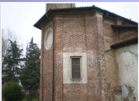
I pluviali sistemati sugli absidi
