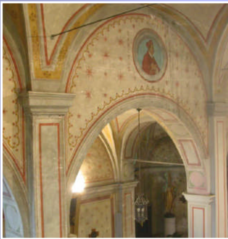
Le superfici interne dopo i lavori
